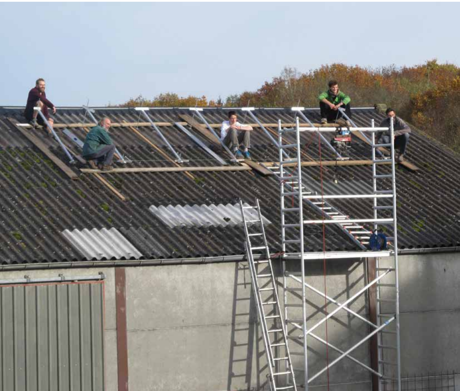
chantier participatif, ferme de la Baillerie, Bousval - 2014
